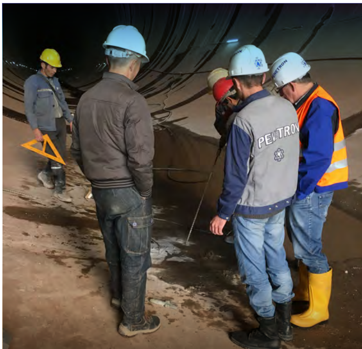
Ремонт строительного тоннеля Рогунской ГЭС
