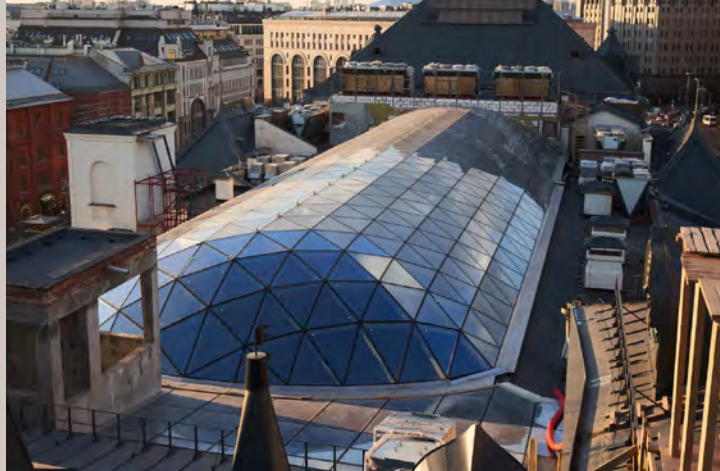
На фото: Инъектирование стен здания музея, Купол над двором-колодцем, www.polytechstroy.ru
