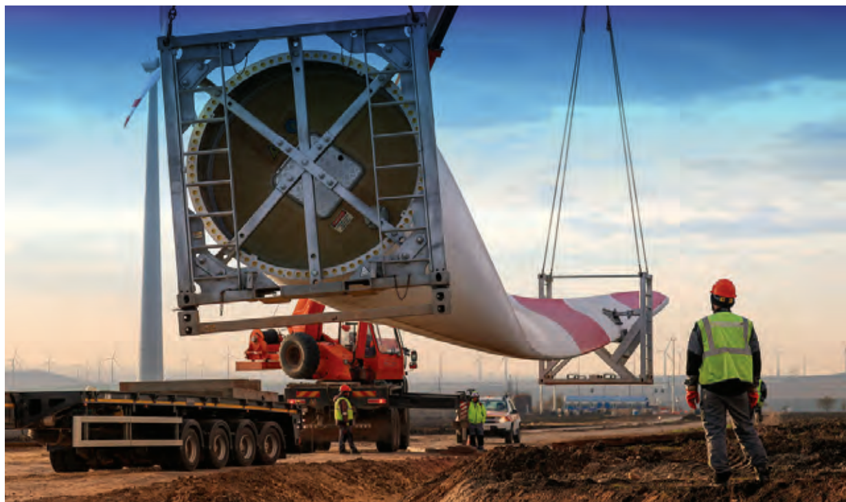
Кочубеевская ВЭС, монтаж ветряка, www.dzen.ru
