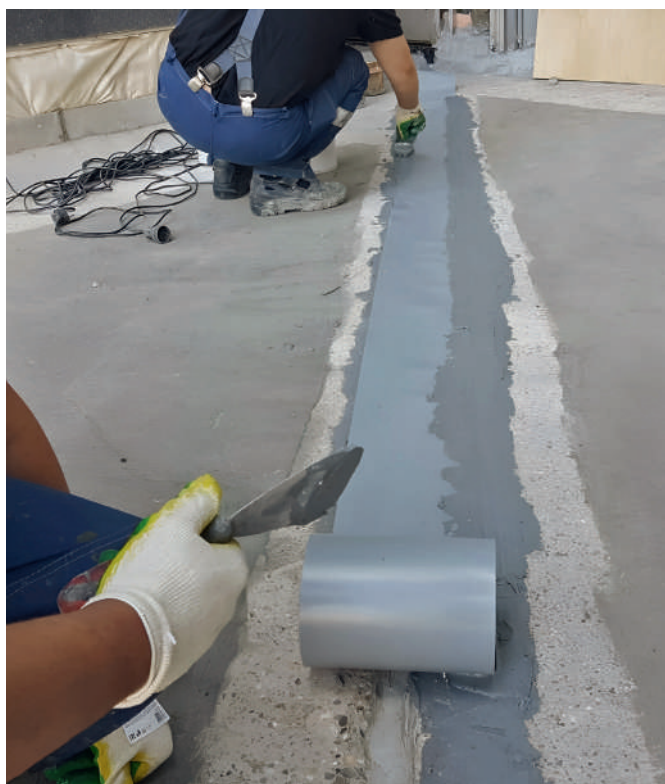
Монтаж системы Пенебанд С
