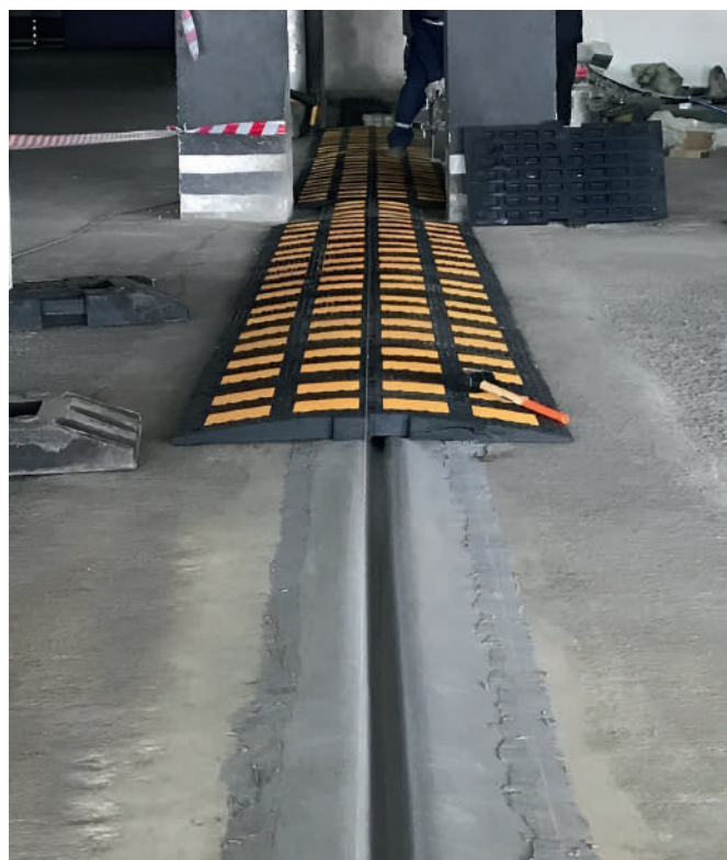
Защита от механических повреждений
