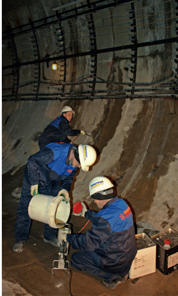
На фото: Работы по инъектированию тоннеля метрополитена на ст. Рассказовка
