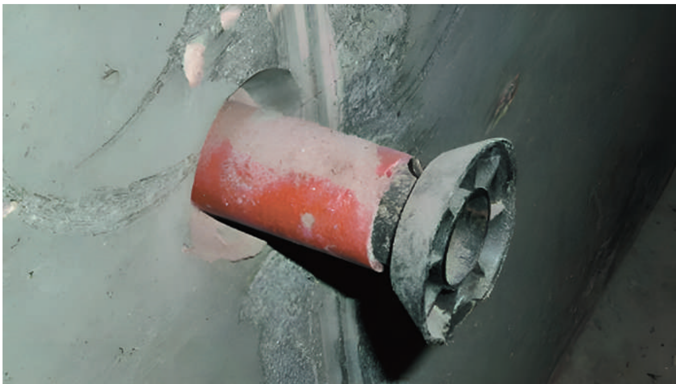
Рис. 10. Втулка от тяжа опалубки
