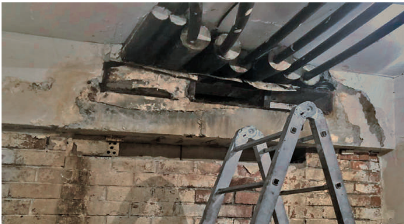
Рис. 8. Места ввода инженерных коммуникаций
