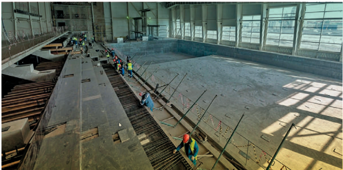
Новый Уренгой, Футбольная арена, бетонирование www.yanao.ru
