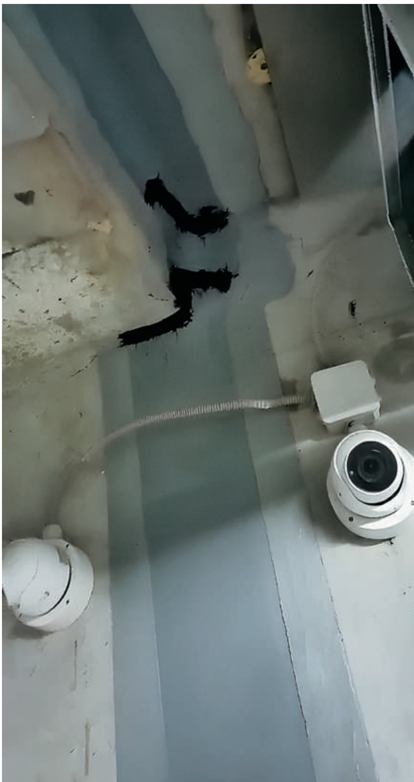
Рис.7. Гидроизоляция деформационных швов
