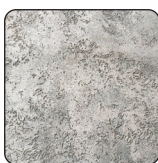
ШТУКАТУРКИ НА ЦЕМЕНТНОЙ ОСНОВЕ
